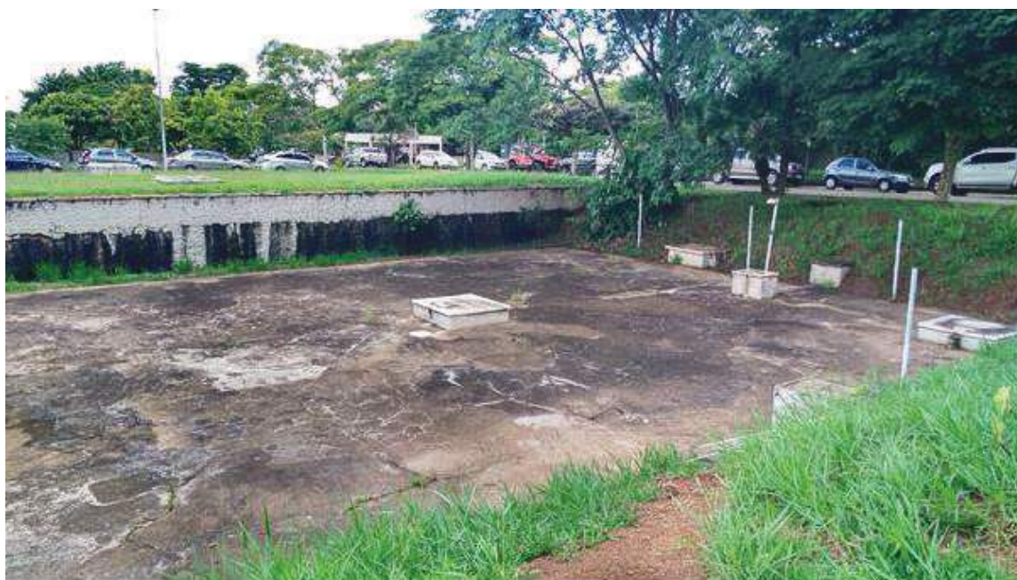
Figura 58 - Sistema ETA (Setor I) - Reservatório Enterrado R1.
