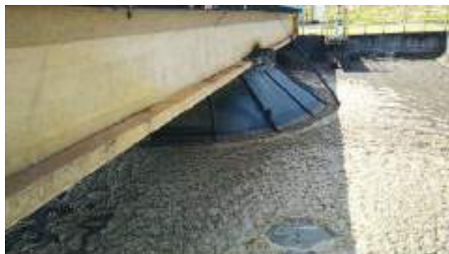
Figura 122 - ETE Franca - Setor 3 - TA1 - Aerador de superfície com campânula para retenção de aerosol.
