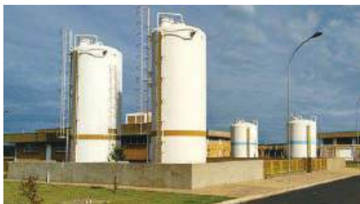
Figura 100 - ETA - Sistema de produtos químicos líquidos.
