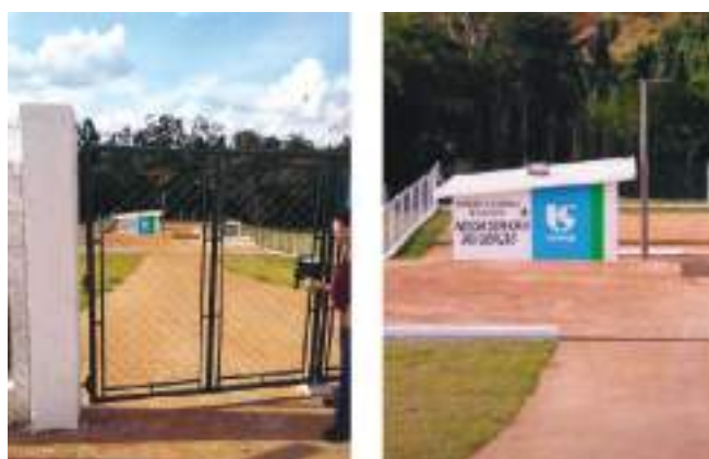
Figura 133 - ETE Nossa Senhora das Graças - Vista geral.
