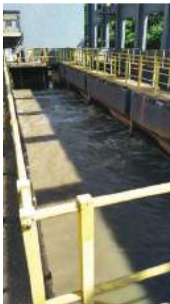
Figura 117 - ETE Franca - Setor 1 - Caixa de areia em movimento espiral airada com canaleta de areia ao fundo.
