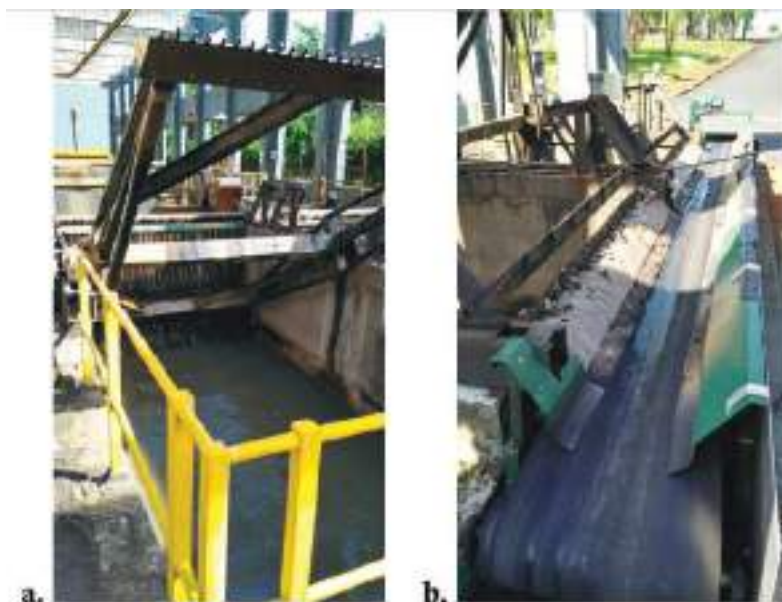
Figura 116 - ETE Franca - Setor 1 - Gradeamento fino mecanizado (a) e esteira do gradeamento fino automatizado mecanizado (b).
