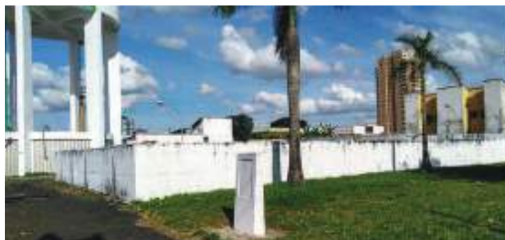
Figura 61 - Sistema Azevedo (SAz) (Setor II) - Reservatórios Azevedo – TN2 e RN2.
