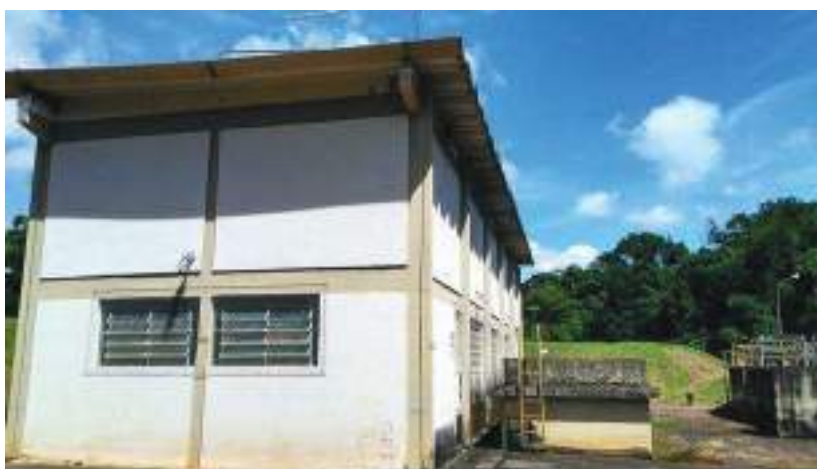
Figura 38 - EPA1 - Vista geral da casa de bombas.
