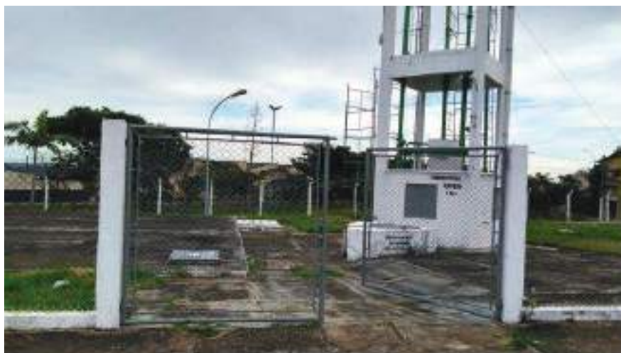
Figura 76 - Sistema Éden (Setor VI) – Reservatórios - Vista geral.
