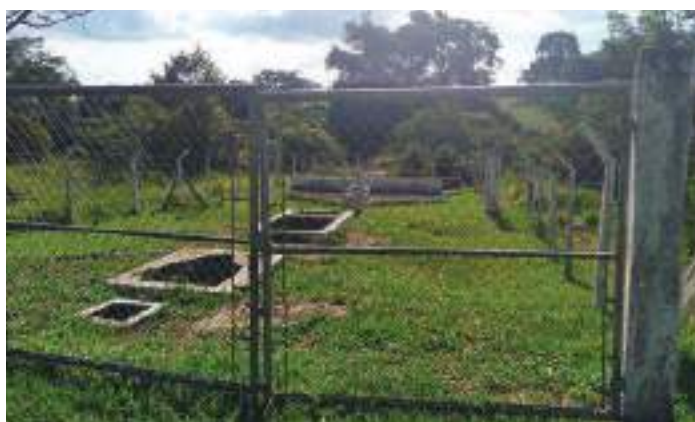
Figura 173 - ETE Fossa Filtro Morada Verde - Vista geral.
