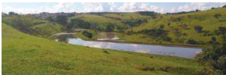
Figura 149 - ETE Aeroporto - Vista geral.
