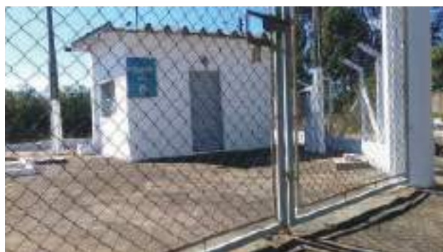
Figura 110 - EEE Ipanema - Vista geral.
