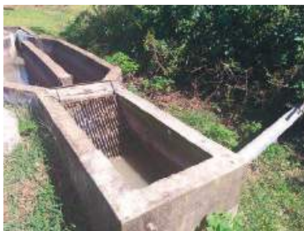
Figura 161 - ETE São Francisco - Chegada do esgoto, gradeamento, caixa de areia e calha Parshall.
