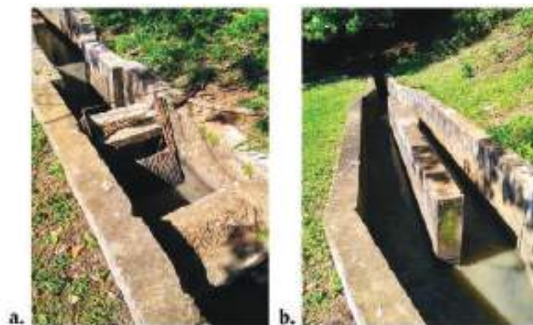
Figura 164 - ETE Paulistano II – Chegada, gradeamento, vertedor (a) e caixa de areia (b).
