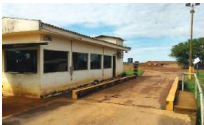
Figura 182 – Entrada e balança do Aterro municipal.
