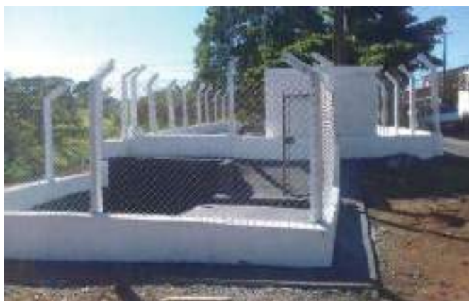
Figura 112 - EEE Palmeiras – Vista geral.
