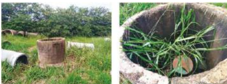
Figura 184 – Poço de monitoramento no Aterro municipal.
