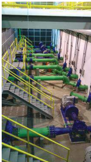
Figura 107 - Complexo de Integração dos Sistemas Norte e Sul - R5A - Casa de bombas do sistema de integração, com isolamento acústico.
