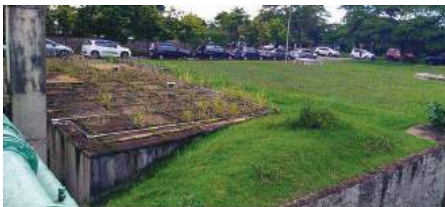
Figura 54 - Reservatório Enterrado R2.
