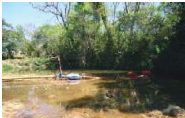
Figura 47 - Captação extra Canoas – Vista geral 2.
