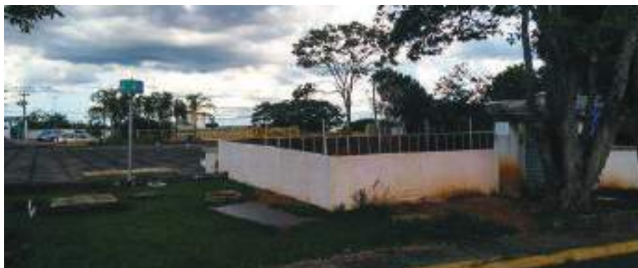
Figura 65 - Reservatório Enterrado RN3 – Vista geral.
