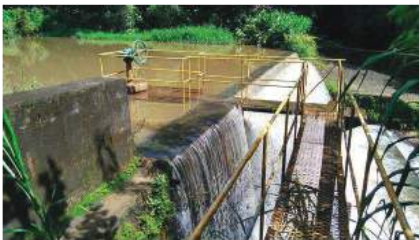
Figura 37 - Captação Pouso Alegre - Barragem de elevação de nível e manobra do descarregador de areia da barragem.
