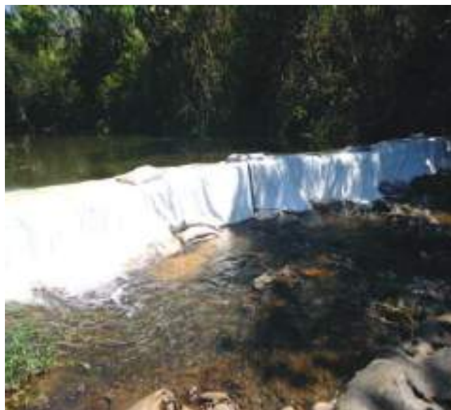
Figura 46 – Captação extra Canoas – Vista geral 1.
