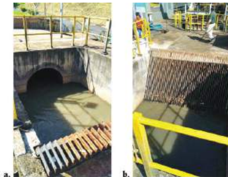
Figura 115 - ETE Franca – Setor 1 - Chegada do esgoto bruto (a) e gradeamento grosseiro (b).
