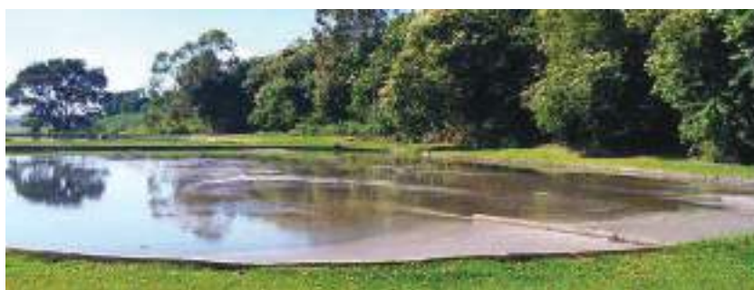
Figura 165 - ETE Paulistano II - Detalhe da Lagoa Anaeróbica.
