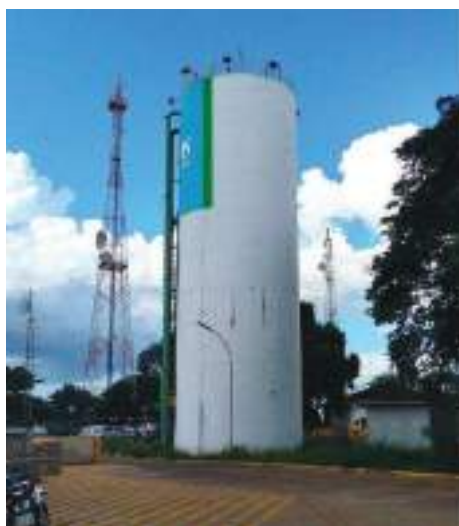
Figura 59 - Sistema ETA (Setor I) - Reservatório TN1.
