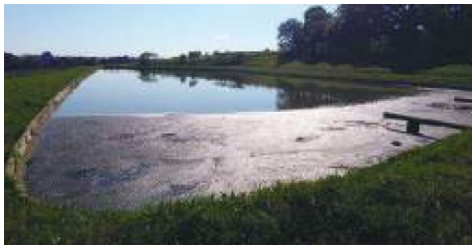
Figura 170 - ETE City Petrópolis - Lagoa facultativa.
