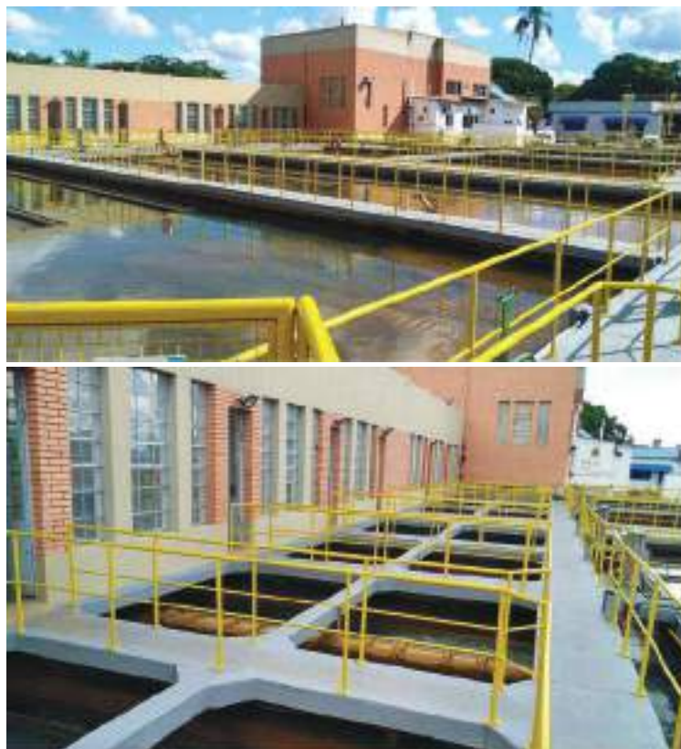
Figura 50 - ETA - Decantadores e 7 Filtros em concreto.
