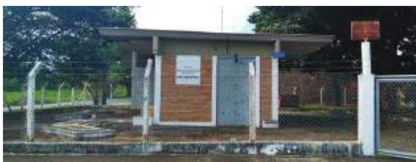
Figura 114 - EEE São Sebastião - Vista geral.
