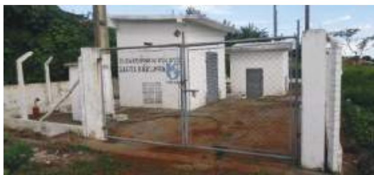
Figura 146 - ETE Santa Bárbara I - Vista geral.
