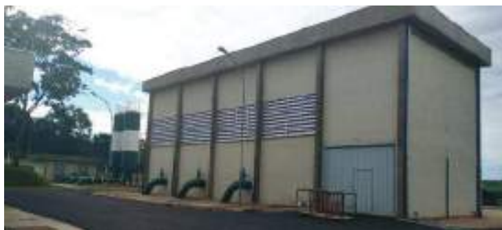
Figura 99 - EEAB 3 - Pátio - Vista geral.
