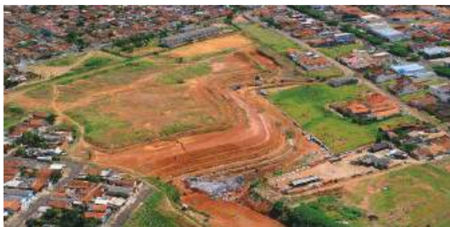
Figura 191 – Vista geral – Aterro das Maritacas.
