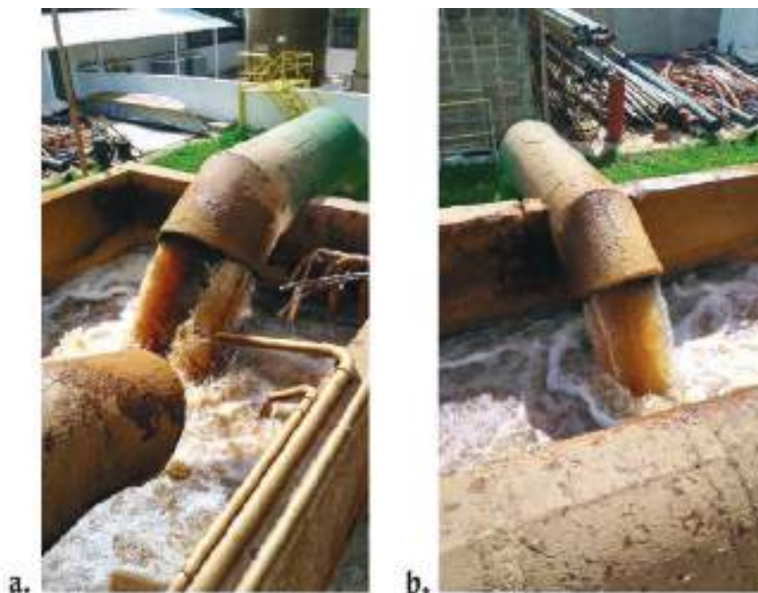
Figura 48 - ETA - Caixa de chegada de Água Bruta – Detalhes da chegada da captação Canoas (a) e chegada da captação Pouso Alegre (b).
