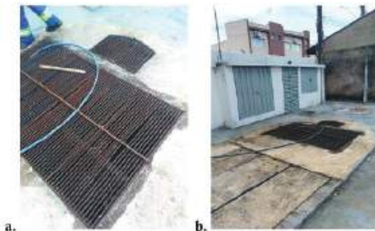
Figura 151 - ETE Paulistano II - Cesto de gradeamento, poço de sucção - vista interna (a), poço de sucção e painel elétrico - vista externa (b).
