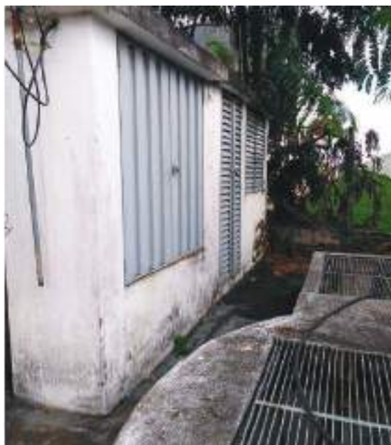
Figura 171 - EEE Morada do Verde - Poço de sucção com cesto de gradeamento e Quadro elétrico.
