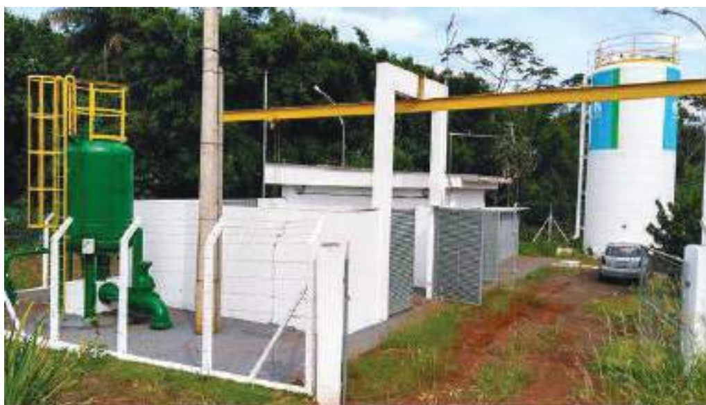
Figura 43 - Sistema Restinga - EEAB - Vista geral.
