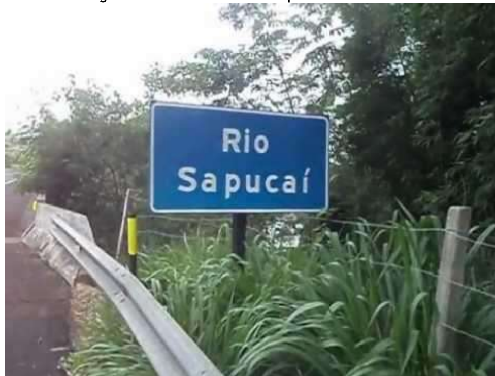
Figura 10: Ponte Sobre o Rio Sapucaí em Franca
