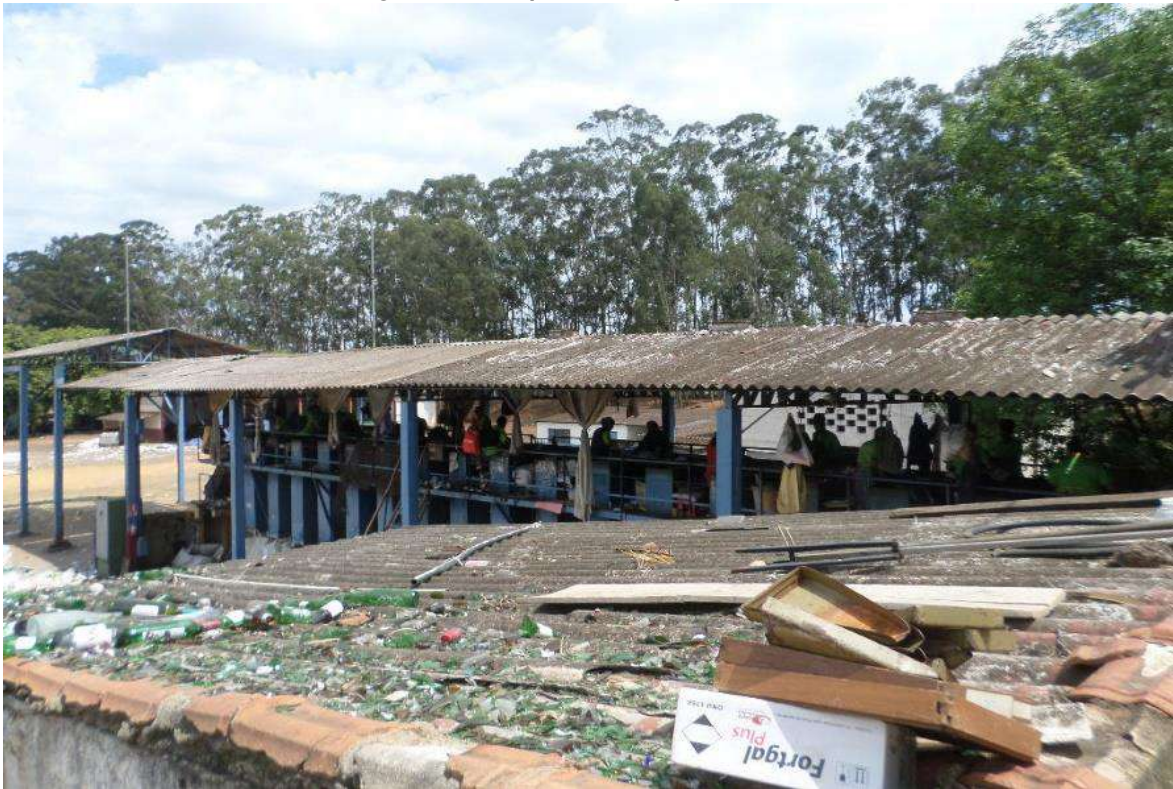
Figura 28: Galpão de Triagem - COOPERFRAN
