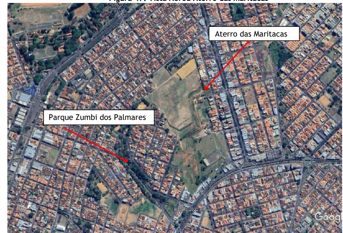
Figura 47: Vista Aérea Aterro das Maritacas
