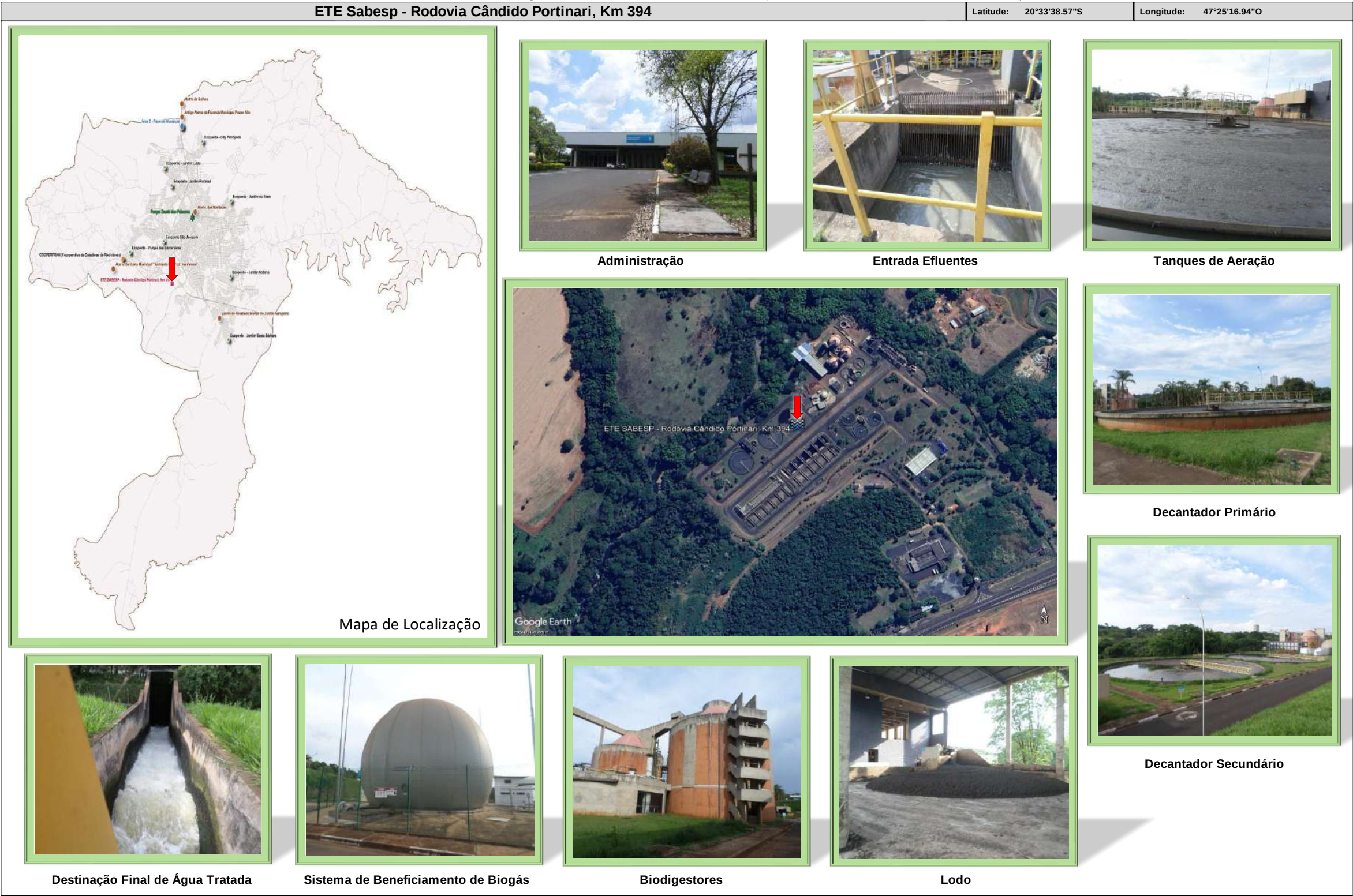
Figura 46: Vistoria da ETE SABESP (Rodovia Cândido Portinari, km 394)
