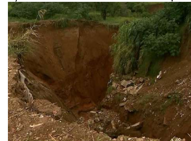
Figura 16: Voçoroca com mais de 10 m no Jardim Aeroporto, em Franca
