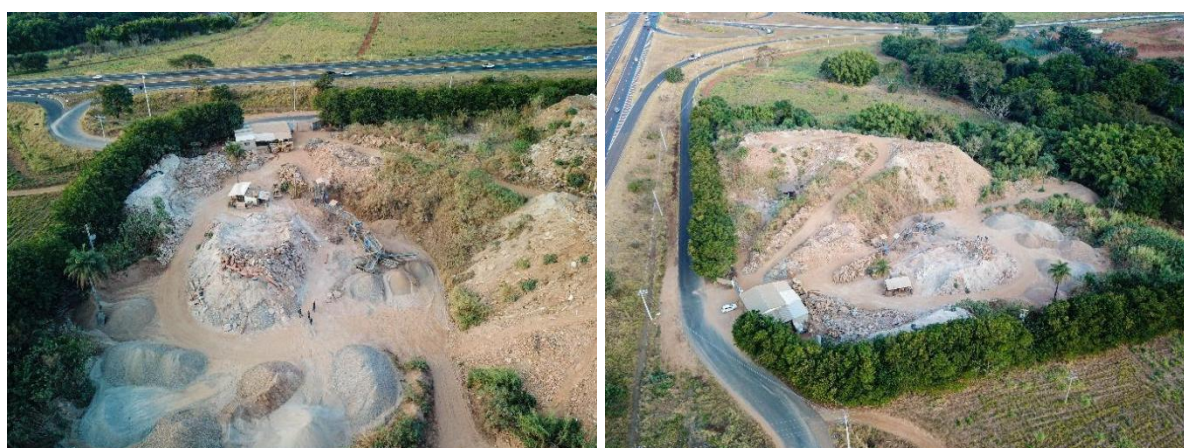
Figuras 46. e 47. Vista geral aérea da Usina de Reciclagem de RCC da SL.
