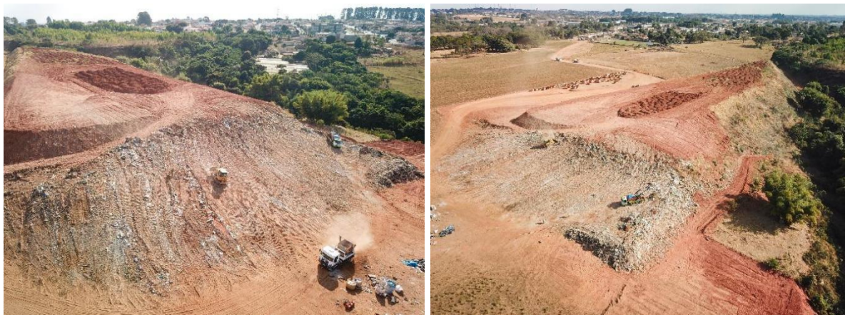
Figuras 54. e 55. Vista aérea geral do aterro de inertes e RCC - Codrate Locação de Máquinas e Caçambas.
