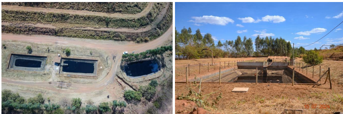
Figuras 40. e 41. Vista aérea das 03 lagoas de chorume do Aterro Sanitário Prof. Ivan Vieira, a direita a lagoa central.
