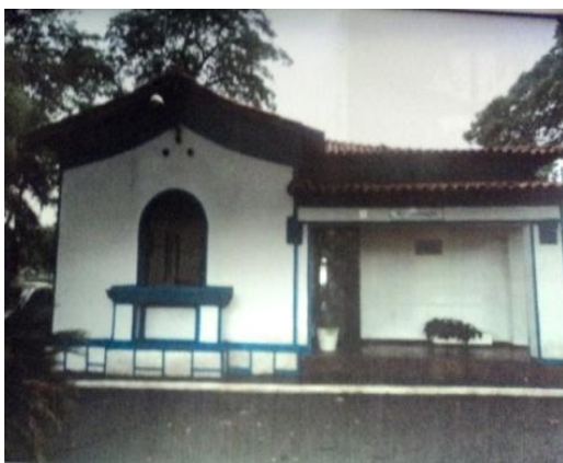
Administração - primeira edificação à direita da entrada do Parque.
