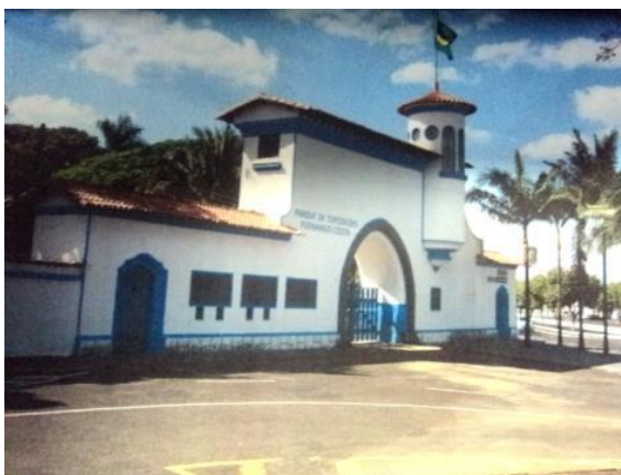
Área Frontal, Pórtico da Fachada situado na Avenida Dr. Flávio Rocha nº 500 e a Rua Cláudio Carvalho s/n.
