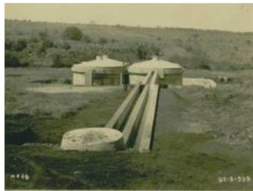
Tratamento de esgotos. Desoneradores, Tanques imhoff e Câmara Seccagem.
