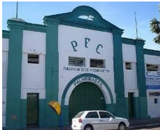
Fachada do Estádio em 2009.
