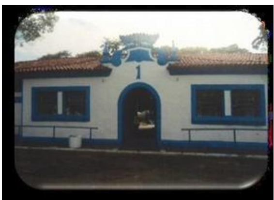
Pavilhão 1 – Baías para cavalos, situadas no lado direito da pista central.
