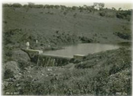
Barragem do Rio Salgado
