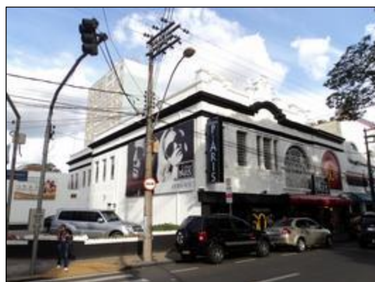
Fachada do prédio em 2021.
