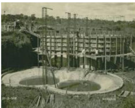
Tratamento de esgotos. Fundação. Tanques Imhoff.
