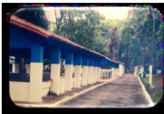
Seis galpões para gado, situados entre a pista central e a área de shows.
