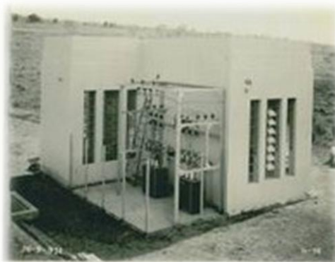
Elevatória do Salgado
