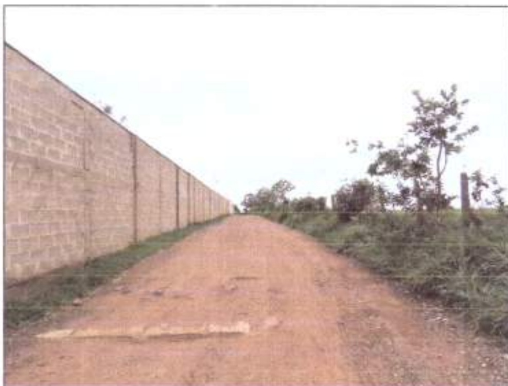
Foto 22: Trecho onde é possível observar a área classificada como Área Urbana Sustentável Fase 2 à esquerda e o muro do Condomínio Residencial Jardim Canadá à direita (UTM 23K 257553 m E; 7727542 m S).
