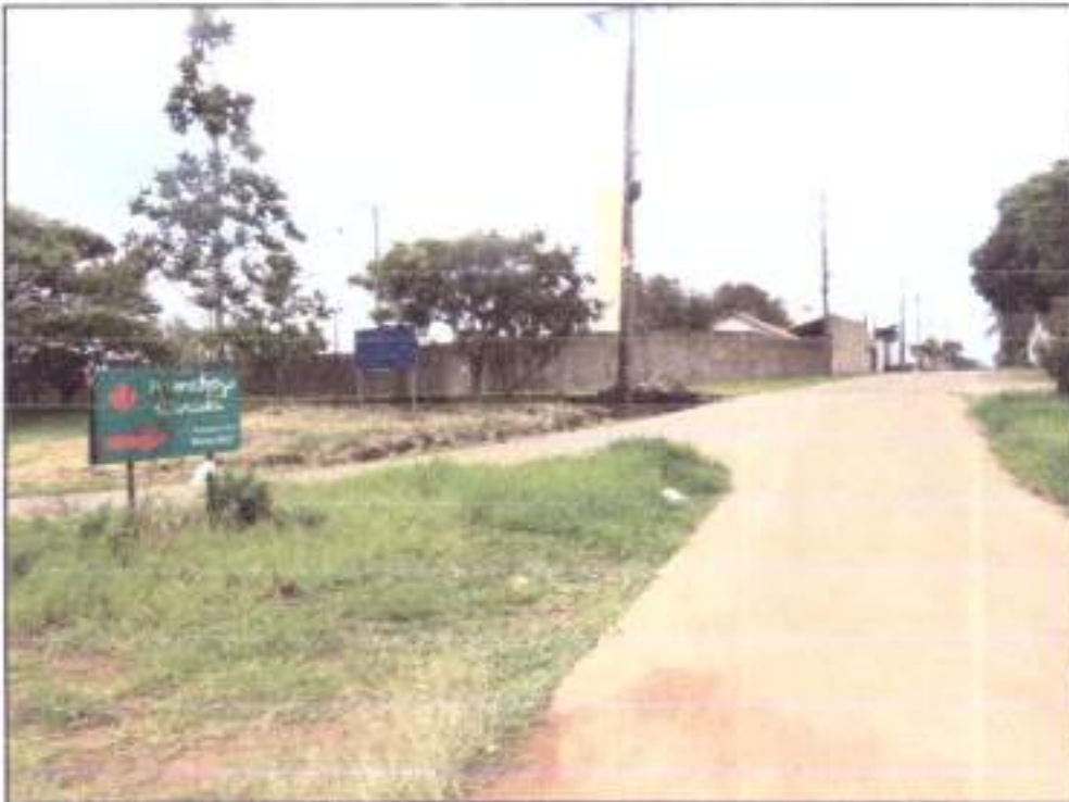
Foto 24: Trecho onde é possível observar a entrada do Condomínio Residencial Jardim Canadá com a Rodovia João Traficante (UTM 23K 257454 m E; 7727509 m S).
