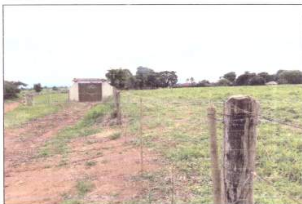
Foto 35: Vista geral de um trecho da propriedade em análise onde foi classificado como Baixa Densidade Nível 1 (UTM 23K 258123 m E; 7727983 m S).
