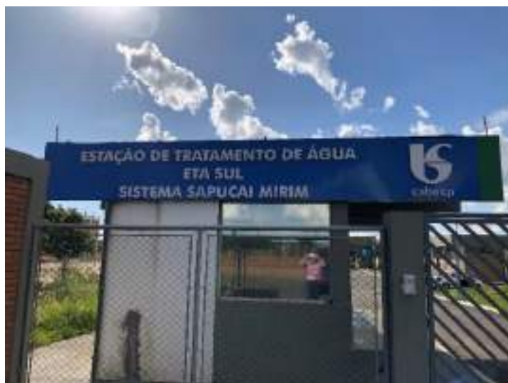
Figura 3.5.2(33) - Entrada da Estação de Tratamento de Água Sul
