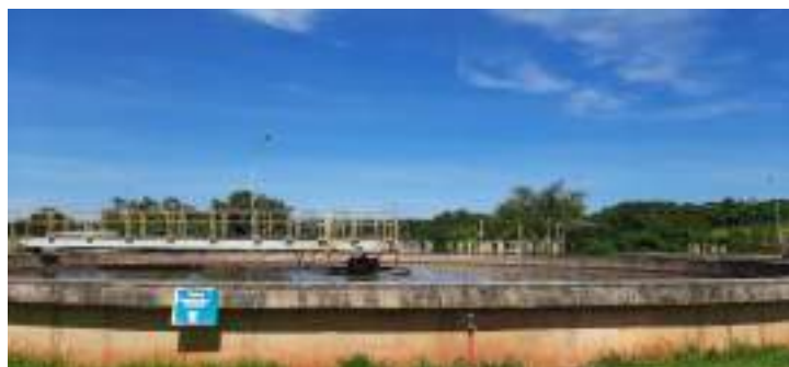
Figura 3.5.3(14) – Decantadores Primários
