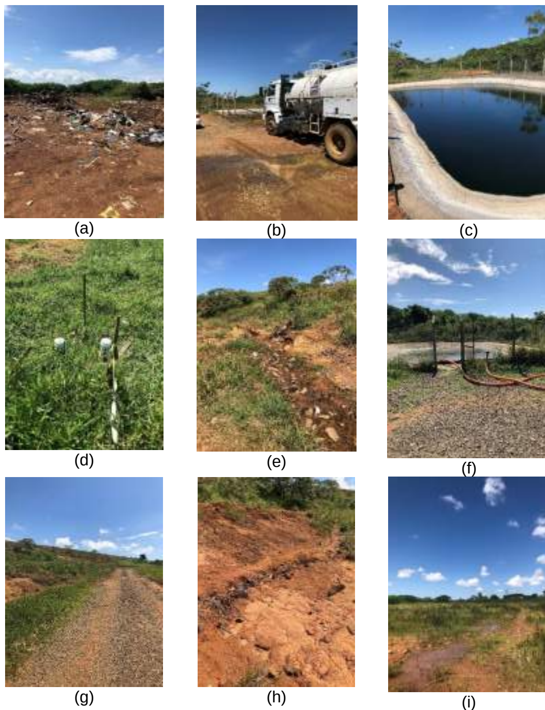
Figura 3.5.4(15) - Aterro da Fazenda Municipal Pouso Alto – (a) acesso ao aterro; (b) caminhão que retira o chorume; (c) primeira lagoa de chorume; (d) pontos de inspeção para coleta de amostra; (e) processo erosivo em talude do aterro; (f) segunda lagoa de chorume com mangueira para retirada; (g) vista lateral do aterro; (h) processo erosivo e falta de cobertura evidenciando as camadas do aterro; (i) vista panorâmica da parte superior do aterro.
