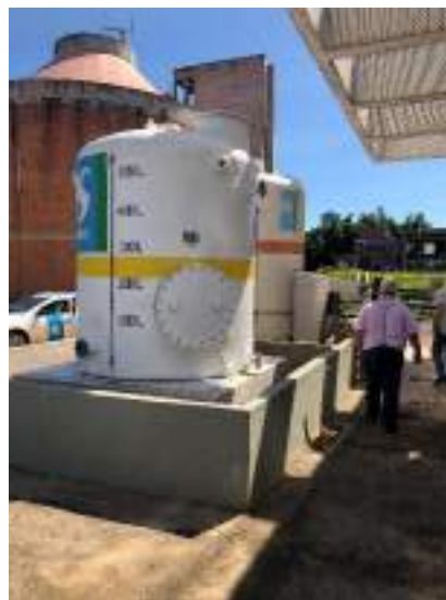
Figura 3.5.3(24) - Produção de água de reúso em tanques de areia e antracito e tanques de Cloro
