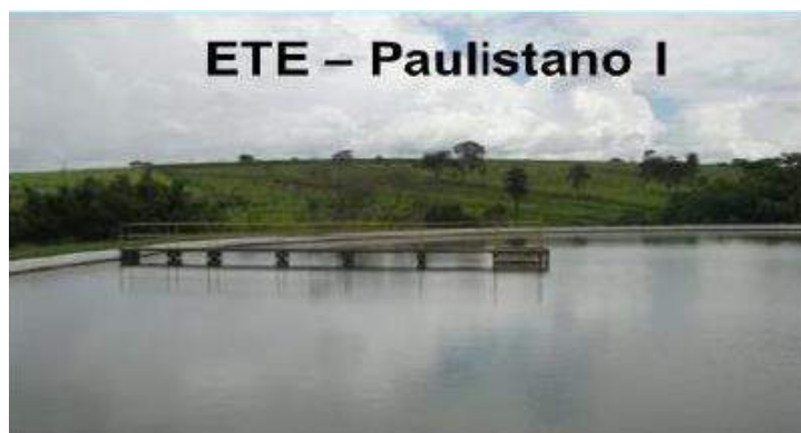
Figura 3.5.3(3) - Estação de Tratamento de Esgotos Paulistano I (Fonte: Sabesp)
