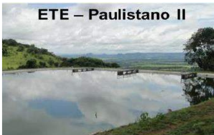
Figura 3.5.3(4) - Estação de Tratamento de Esgotos Paulistano II
