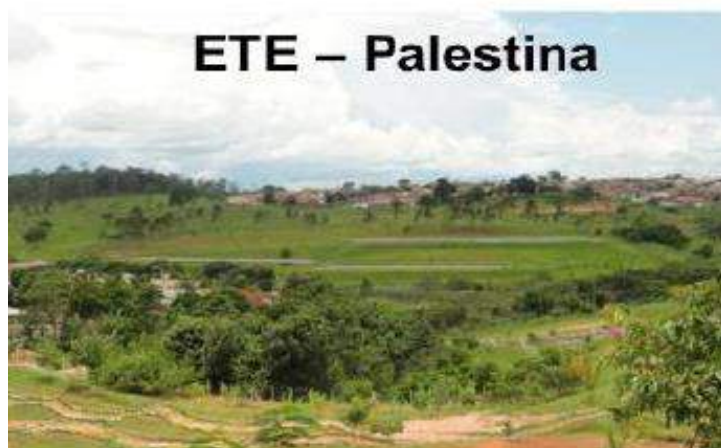
Figura 3.5.3(7) - Estação de Tratamento de Esgotos Palestina
