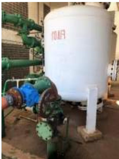
Figura 3.5.3(24) - Produção de água de reúso em tanques de areia e antracito e tanques de Cloro
