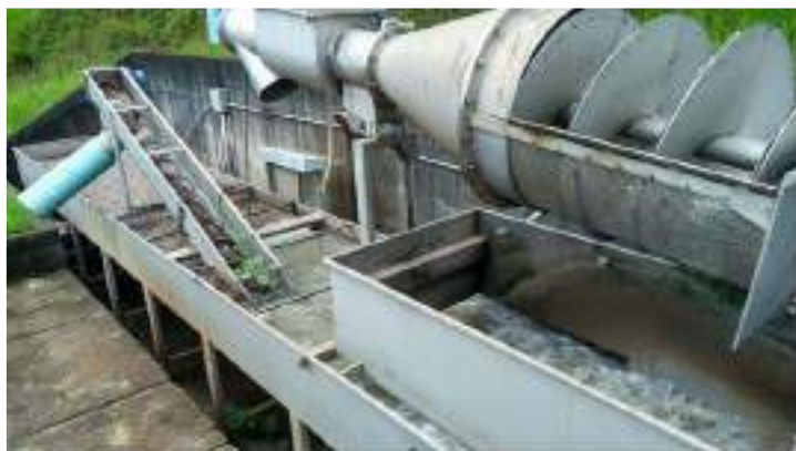
Figura 3.5.3(28) - Caixa de areia automatizada (rosca sem fim)
