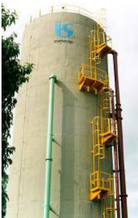
Figura 3.5.2(31) – Reservatório de Água para Lavagem dos Filtros
