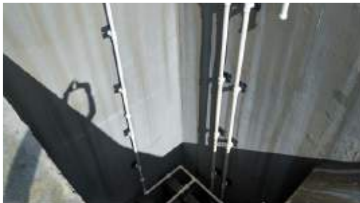
Figura 3.5.2(34) – Caixa de chegada de água
