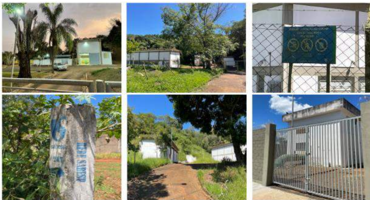
Figura 5.1(17) - Seleção de registros fotográficos realizados sobre os sistemas de captação e abastecimento de água potável existente em Franca, obtidos nos percursos das vistorias.
