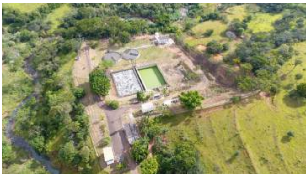
Figura 3.5.3(26) - Estação de Tratamento de Esgotos Luíza
