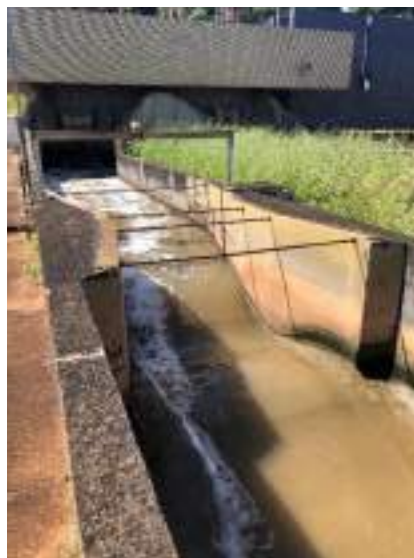
Figura 3.5.3(15) – Tanques de aerção e saída através de medidor de vazão
