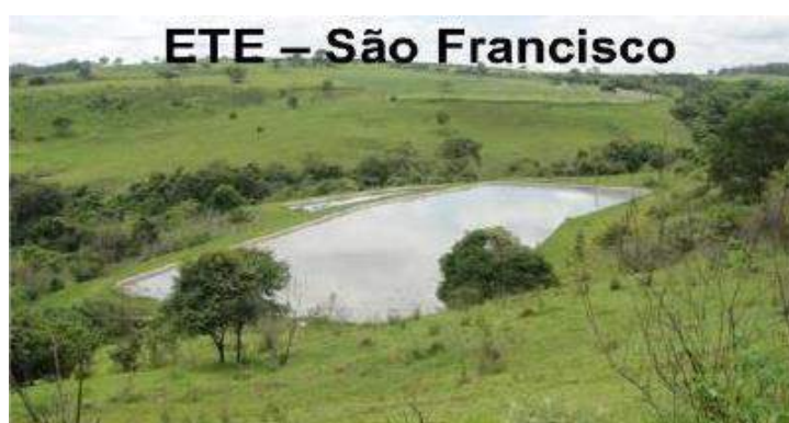
Figura 3.5.3(6) - Estação de Tratamento de Esgotos São Francisco
