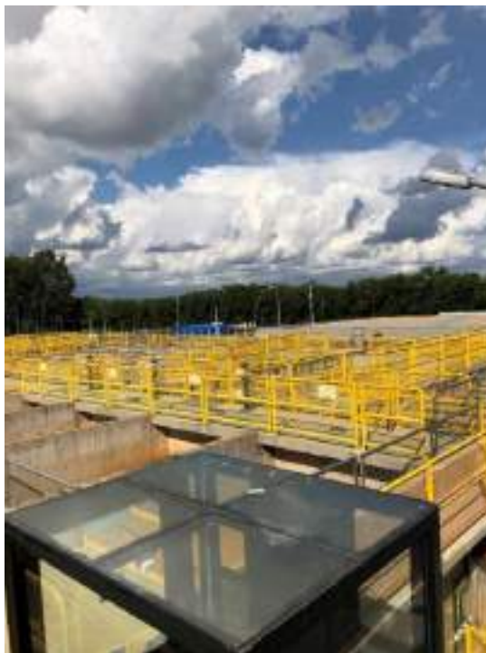
Figura 3.5.2(37) - Floculadores hidráulicos
