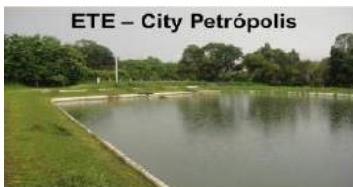
Figura 3.5.3(5) - Estação de Tratamento de Esgotos City Petrópolis
