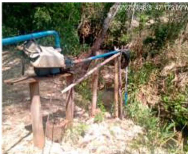
Figura 3.3.5(4) – Exemplo de uso – captação superficial para irrigação de hortaliças (Foto PMA, 2021)
