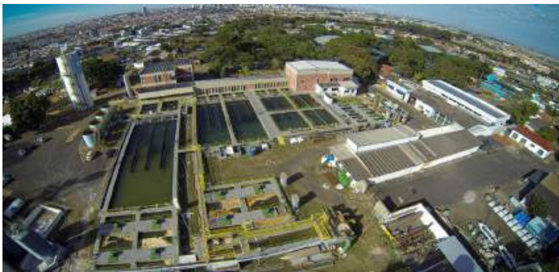
Figura 3.5.2(23) – Vista aérea ETA Norte
