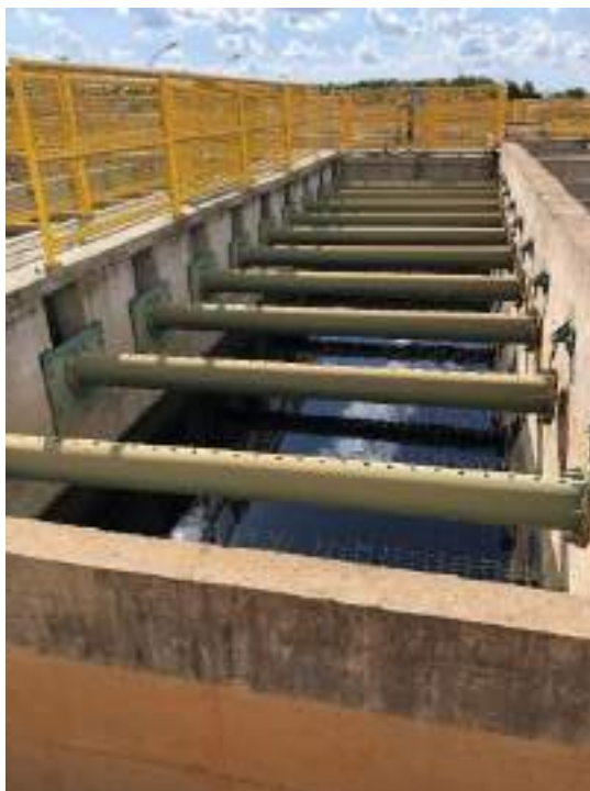
Figura 3.5.2(38) - Decantadores de módulos tubulares
