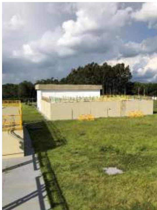
Figura 3.5.2(43) - Reservatório de água tratada, poço de sucção e estação de bombeamento
