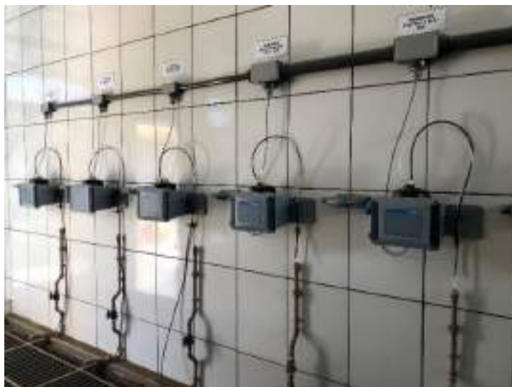
Figura 3.5.2(42) - Analisadores automáticos
