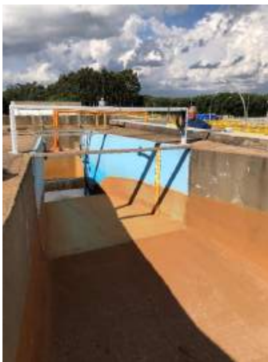
Figura 3.11.2(35) - Medidor Parshall de vazão
