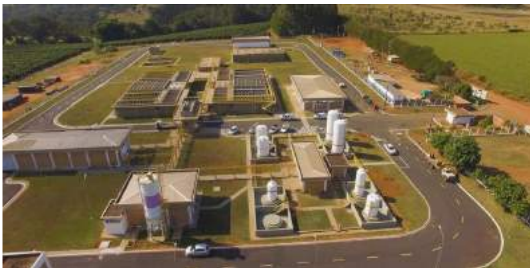
Figura 3.5.2(32) - Vista aérea da Estação de Tratamento de Água Sul
