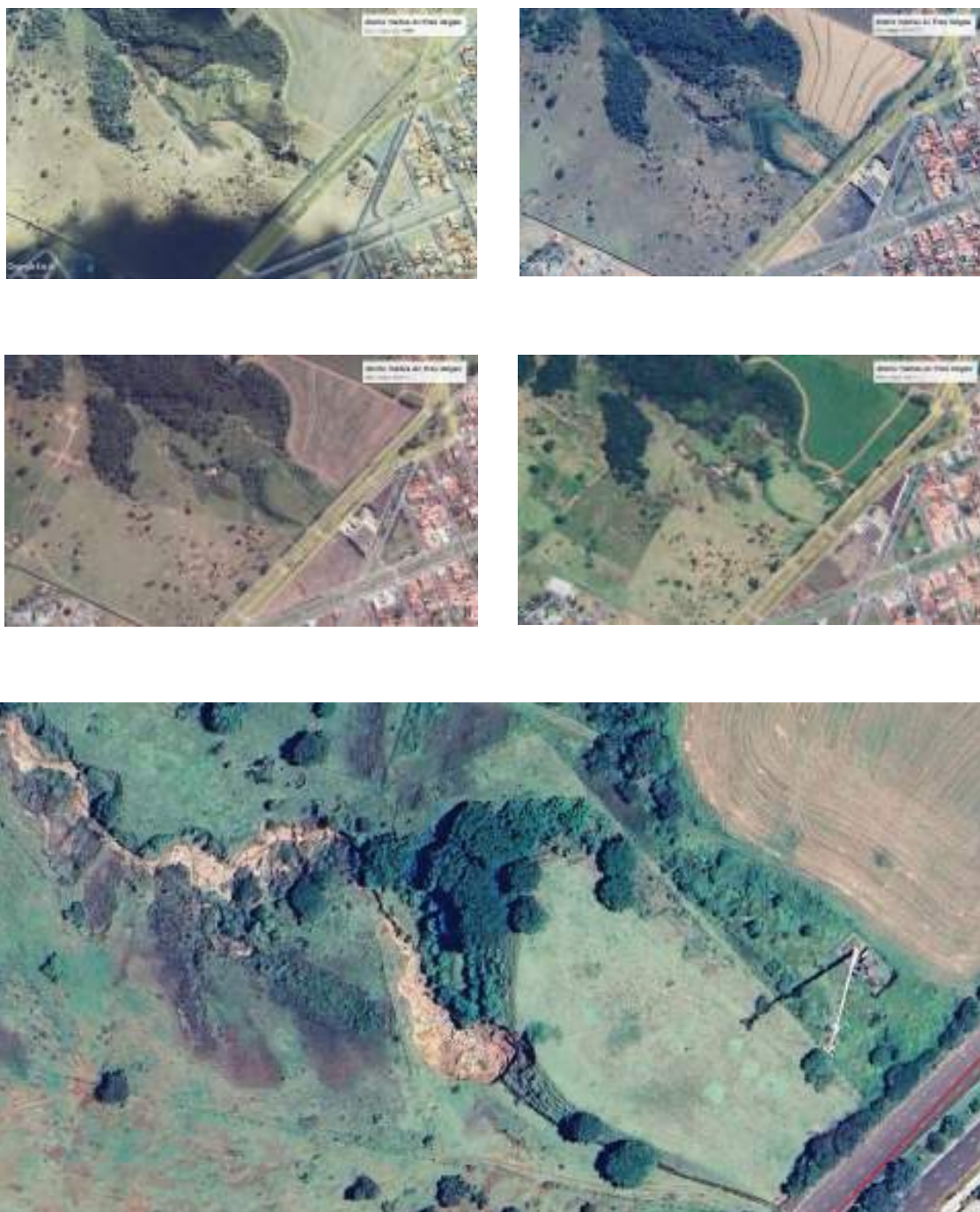
Figura 3.5.5(7) – Evolução de erosão ao lado do aterro de inertes desativado da Av. Presidente Vargas com destruição da drenagem na região
